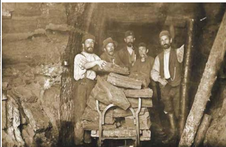
Arbeiter im Stollen.
